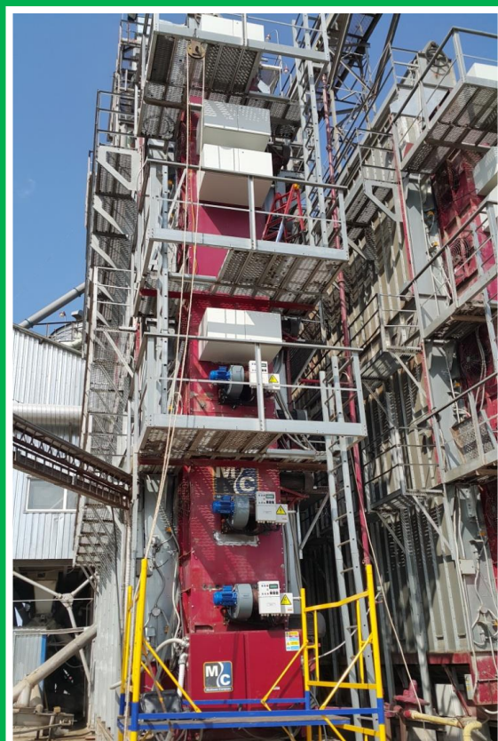
ВСТАНОВЛЕННЯ ПАЛЬНИКІВ PERIFLAME ТА МОДЕРНІЗОВАНИХ КАМЕР ЗГОРЯННЯ НА АМЕРИКАНСЬКІ ЗЕРНОСУШАРКИ MATHEWS
